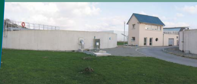
La station d'épuration de Saint-Renan permet de traiter les eaux usées de l'équivalent de 12 000 habitants. L'eau épurée est rejetée dans la rivière de l'aber Ildut.
